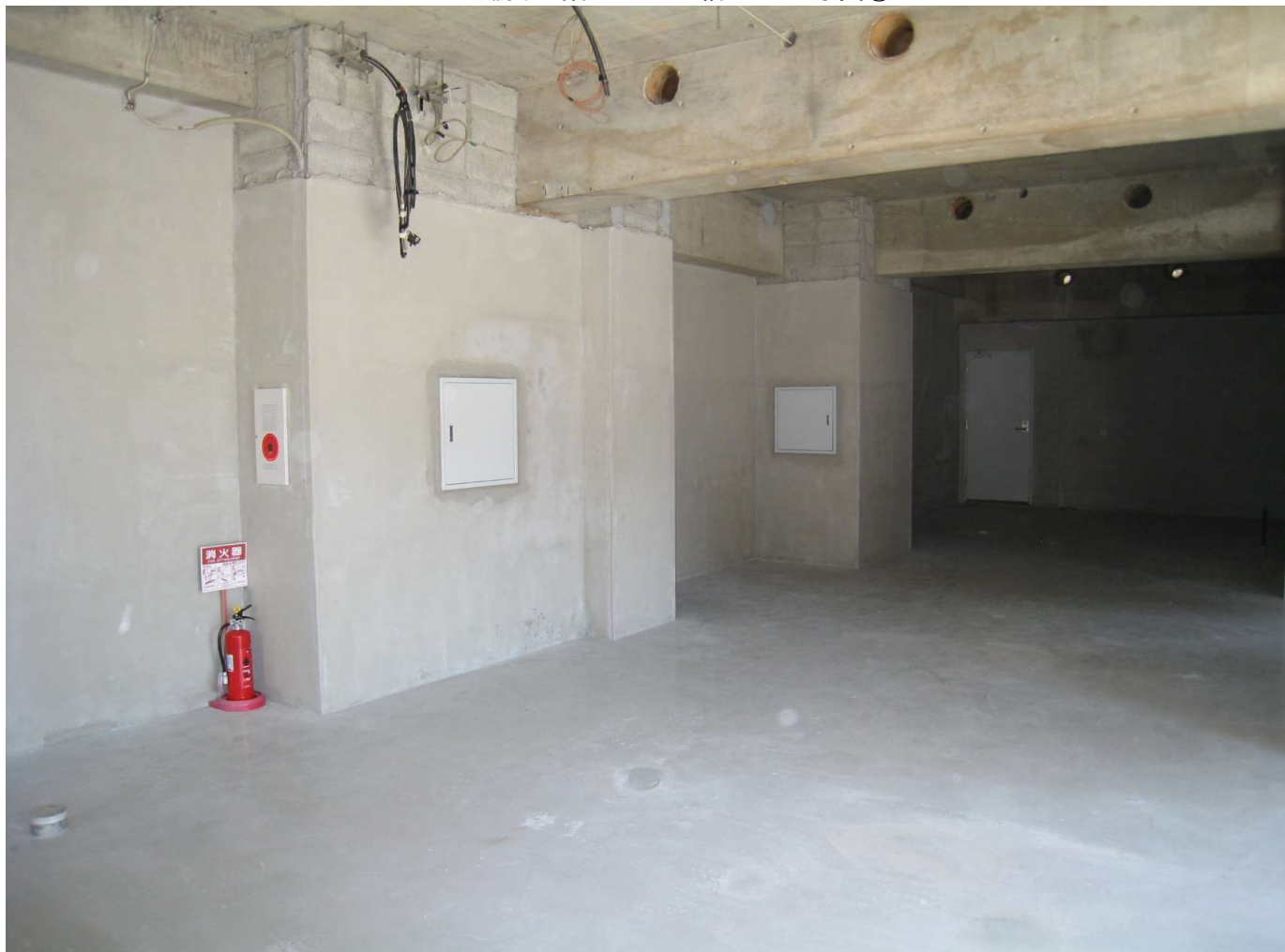
カーム鷹取1階 テナント借室内の写真③
