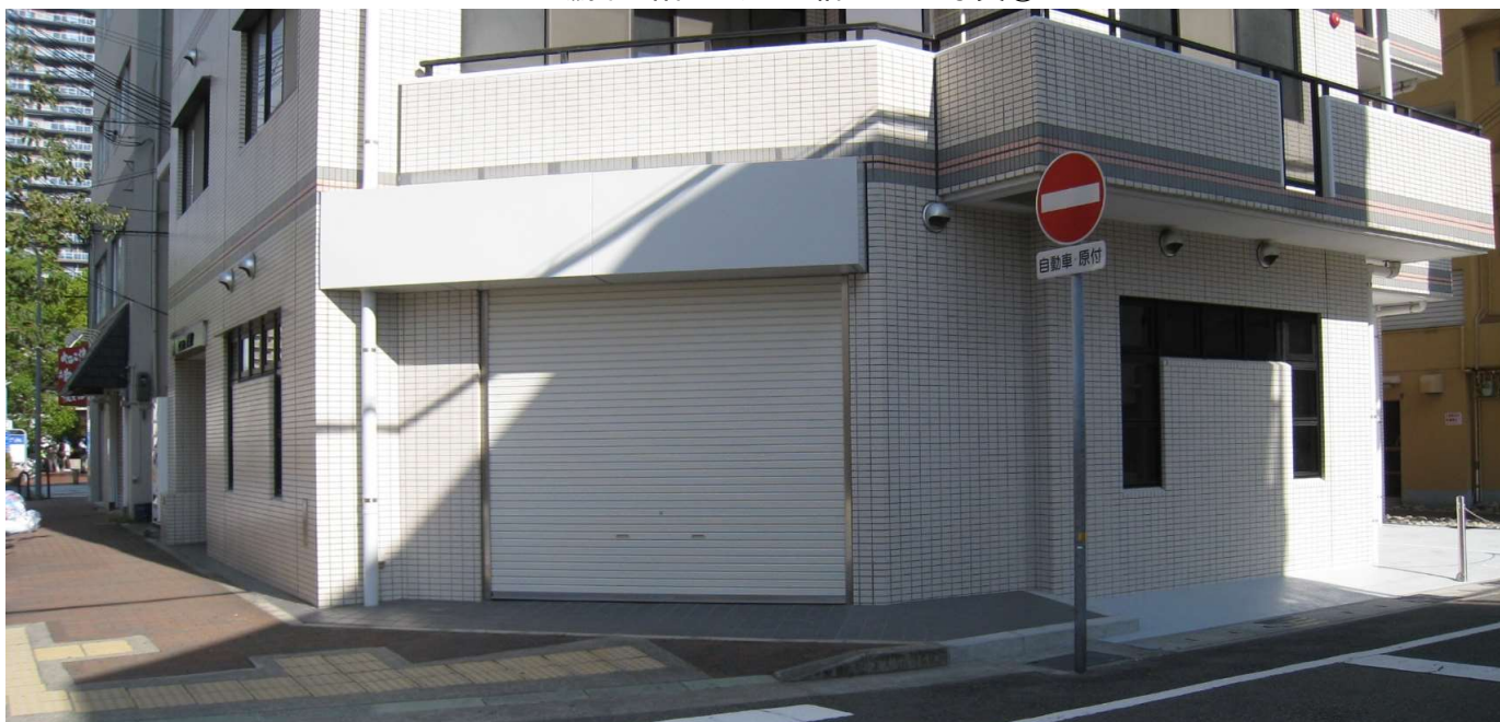
カーム鷹取1階 テナント借室内の写真①
