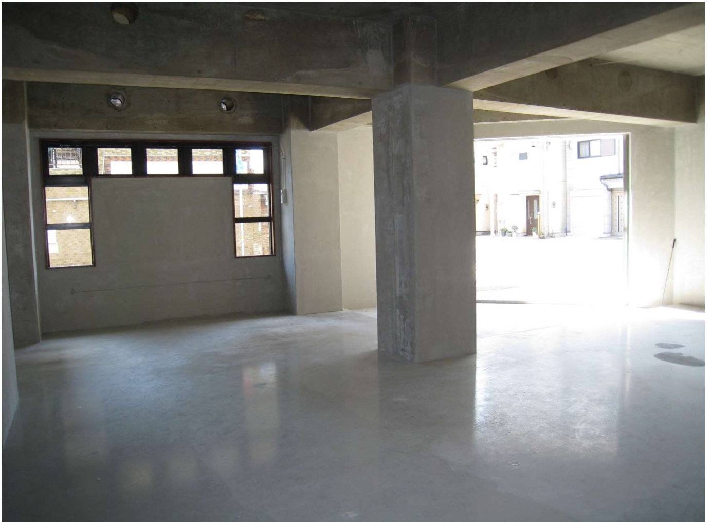
カーム鷹取1階 テナント借室内の写真④
