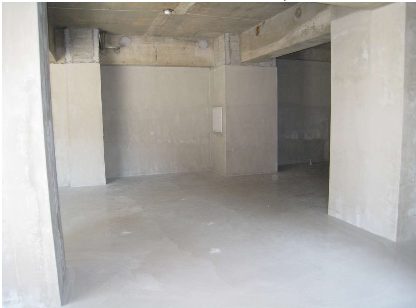
カーム鷹取1階 テナント借室内の写真⑤
